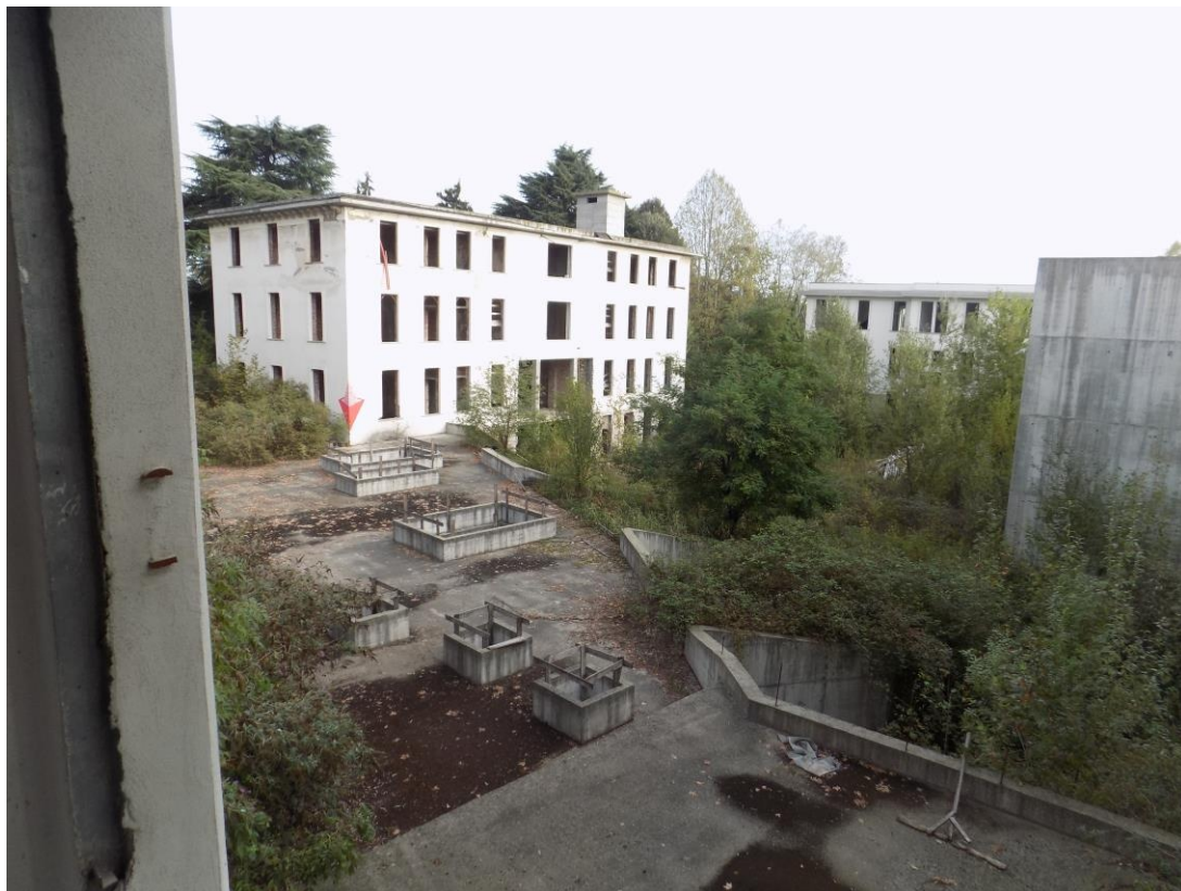
Corte interna tra i fabbricati nella quale sono stati effettuati degli scavi poi sospesi
